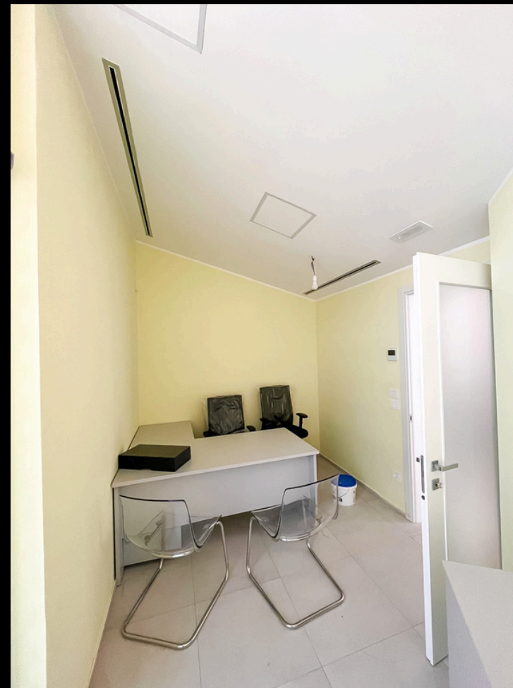
VMC centralizzata combinata con impianto VRF per clima a incasso
