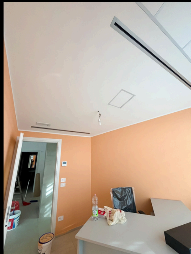
VMC centralizzata combinata con impianto VRF per clima a incasso
